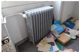
Radiateur fonte sur pied - B016 6 colonnes / 11 éléments
