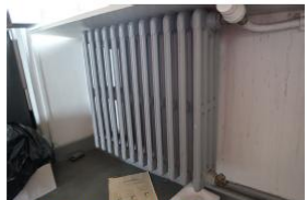
Radiateur fonte applique - B016 4 colonnes / 12 éléments
