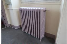
Radiateur fonte sur pied - B016 6 colonnes / 12 éléments
