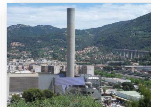
Centre de valorisation énergétique
