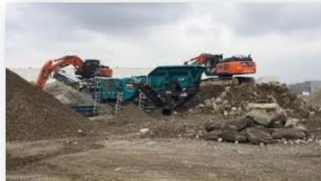
Plateforme de tri/concassage/criblage
