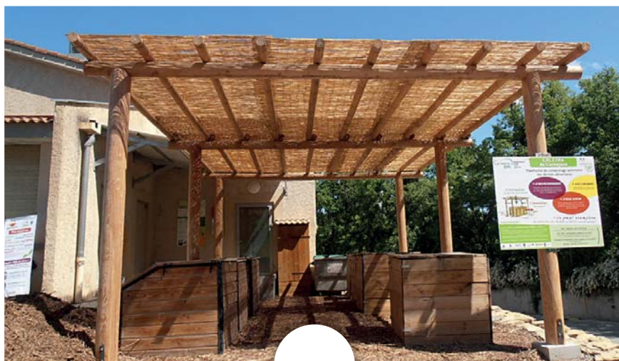
Compostage autonome en bacs Lycée Carnejane, Digne - 2013
